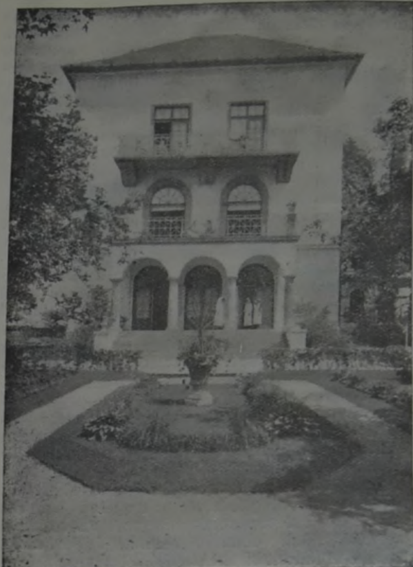
A budapesti „Bethesda” ref. kórház legújabb épült szárnya. Nagy balkonokkal, szép stílusban. Itt van a fogászati és gyermekrendelő. Előtte az izléses parkírozás egy része.
