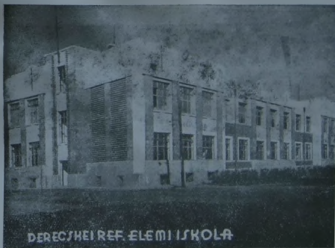
A derecskei református Egyház új elemi iskolája. Magyarországnak ez jelenleg az egyik legesetlegmodernebb vidéki ilyen iskolaepelete. Van benne lúrdó, terrasz—nap—iskola stb.
